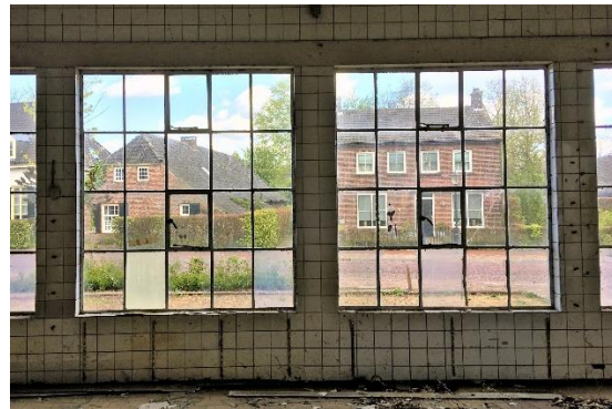
stalen ramen binnenzijde
