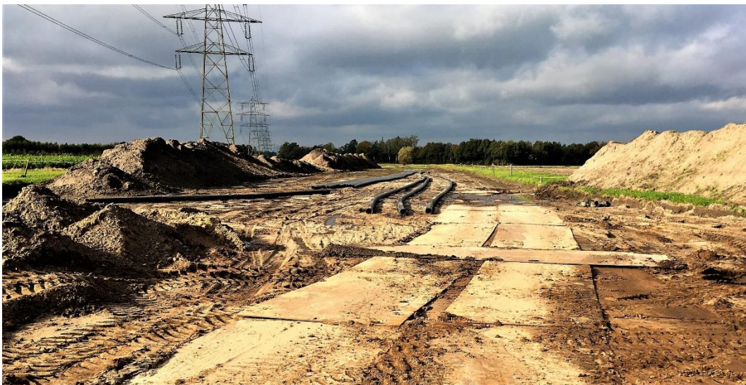
aanbrengen hoogspanningsleiding, donkere wolken voor het landschap
